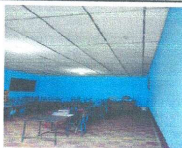
Foto 2: Cielo falso y pintura, dentro del aula de Preprimaria, para las dos jornadas.
