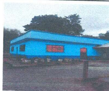
Foto 6: Pintura exterior, frente a la Dirección JV, frente al aula de Preprimaria y bodega. Balcon frente y a un costado de la Dirección.
